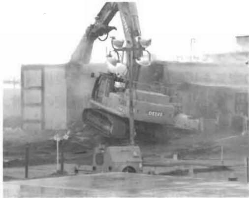
図3 重機での施設の取壊し
